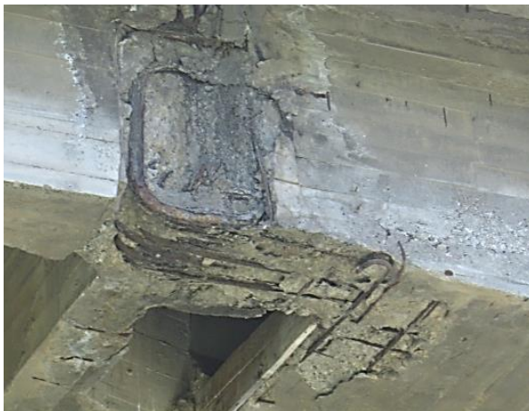
Patología detectados en Inspecciones de Apoyos a Media Madera
