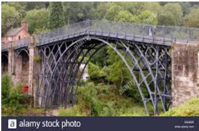
Puente Coalbrookdale sobre el Severn (30m luz ; 1779)
