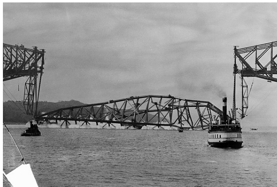
Accidente durante el montaje por izado del puente de Quebec (1916), 86 muertos
