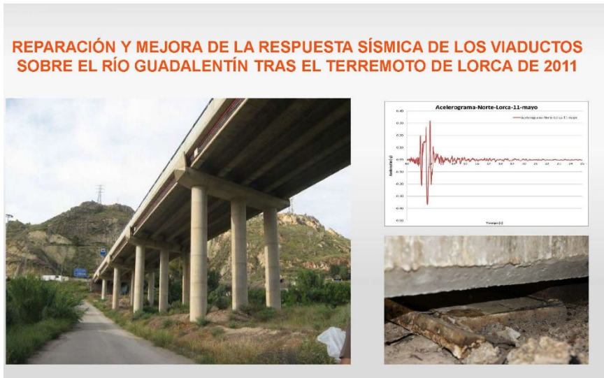
Reparación y mejora antisísmica viaducto Guadalentín (terremoto de Lorca)
