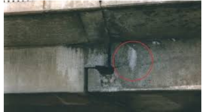
Detalle del Apoyo a Media Madera de Hormigón antes del derrumbe (Montreal)
