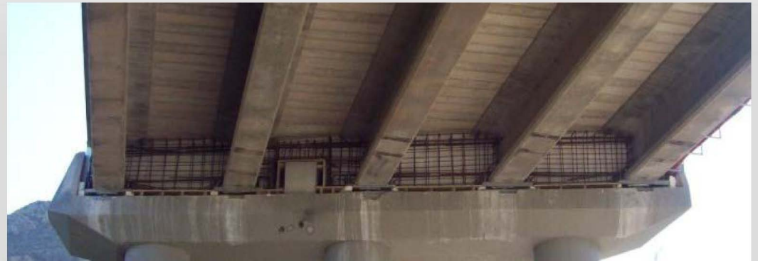
Ejecución de riostras y topes sísmicos
