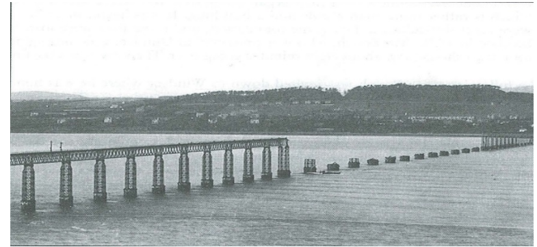
Tay Bridge después del accidente (1879) al paso de un tren bajo una fuerte tormenta, 80 muertos
