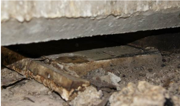
Detalles inadecuados apoyos no anclados
