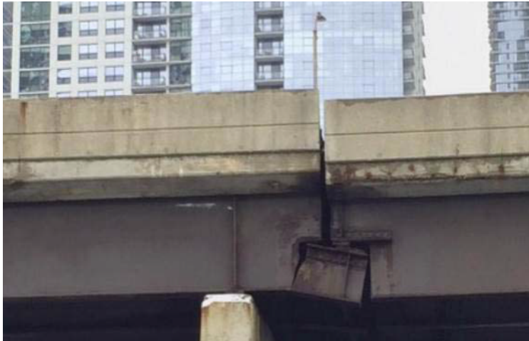
Rotura por fatiga en un Apoyo Metálico a Media Madera en un puente en Chicago
