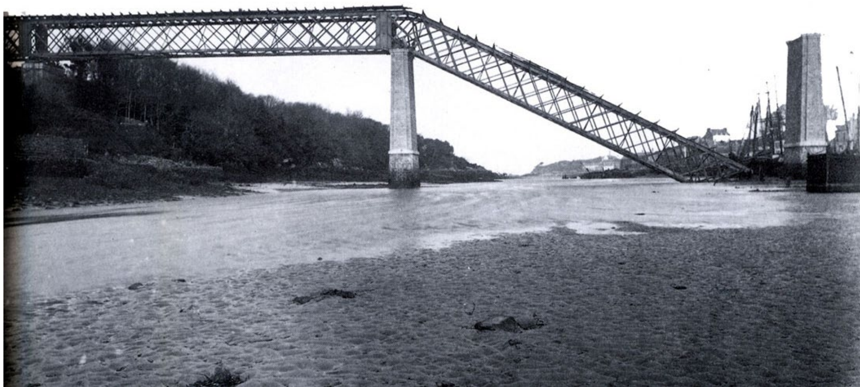
Pandeo del cordón comprimido durante el proceso de lanzamiento
